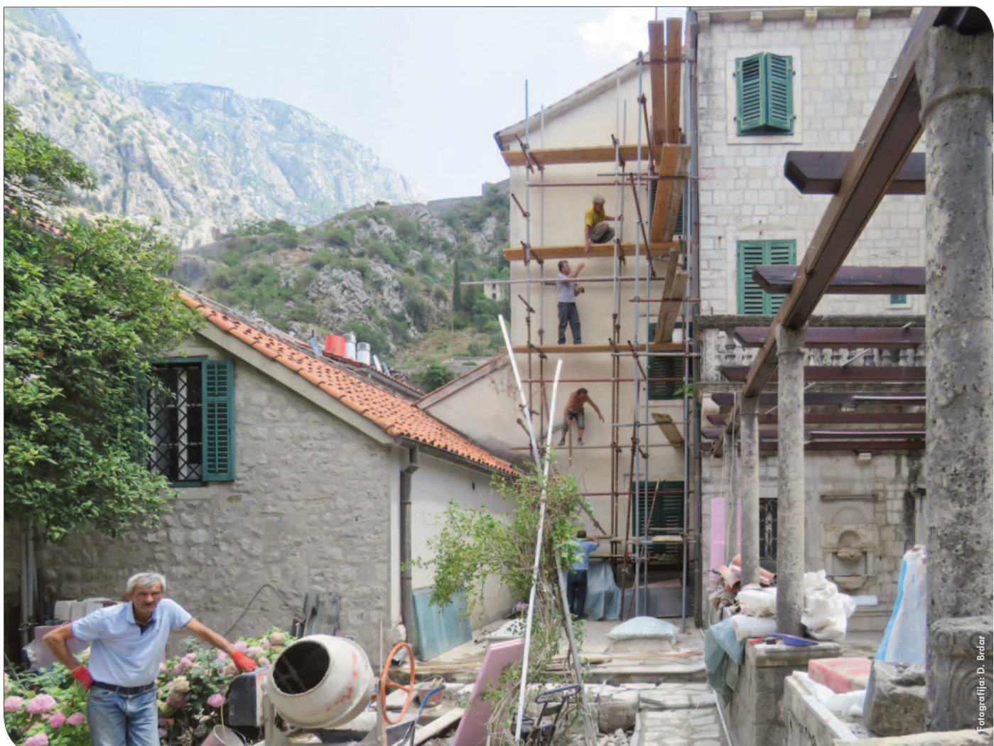
Vanjski radovi na fasadi i taraci Palate Grgurina (snimljeno 19. juna)
